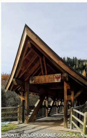
PONTE CICLOPEDONALE-SORAGA (TN)
